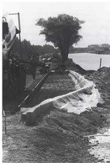
De hoge putten zijn nodig i.v.m. de hoogte van het schuimbeton
