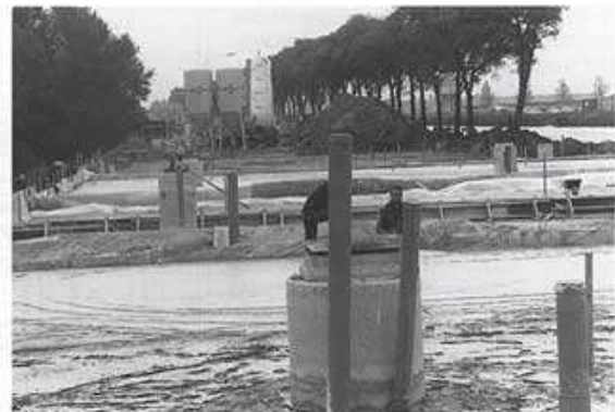
De hoge putten zijn nodig i.v.m. de hoogte van het schuimbeton
